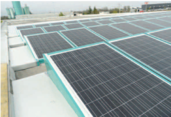
Ubicazione / Site Roveredo in Piano (PN) Potenza / Capacity 18 kW p
