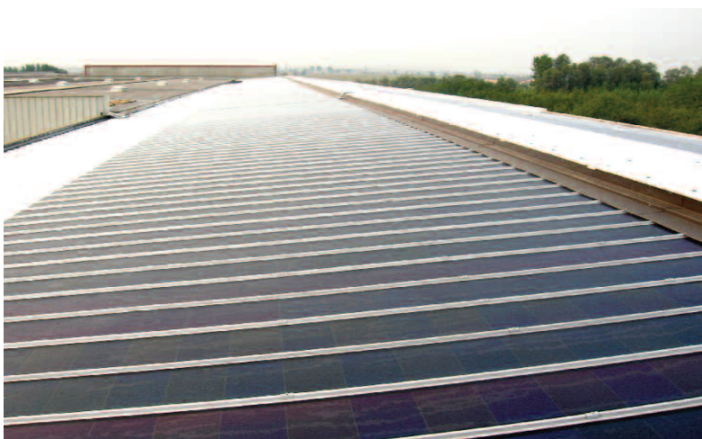
Ubicazione / Site Torre San Giorgio (CN) Potenza / Capacity 97 kW p
